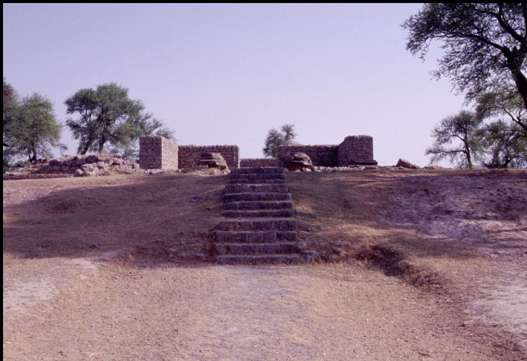
タキシラー ジャンディアル寺院 (パキスタン 北西辺境州 タキシラー県) 寺院正面
